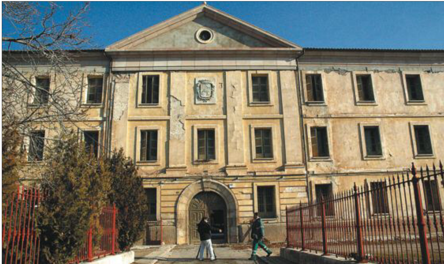
Edificio del Hogar del Comandante Aguado, en Teruel, que albergará el Museo Nacional de Etnografía.
