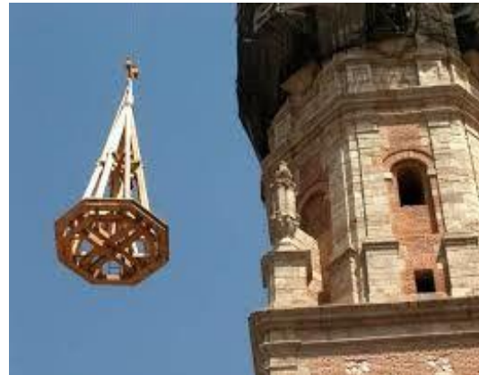
La Solana. Restauración de la iglesia y el chapitel de la torre.
