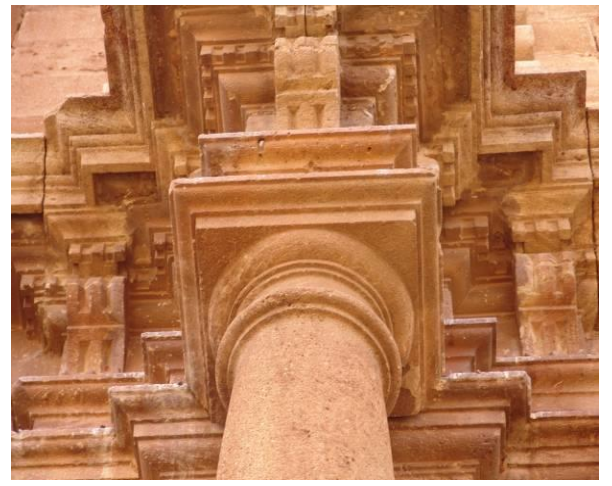
Detalles de las fachada principal y lateral.
